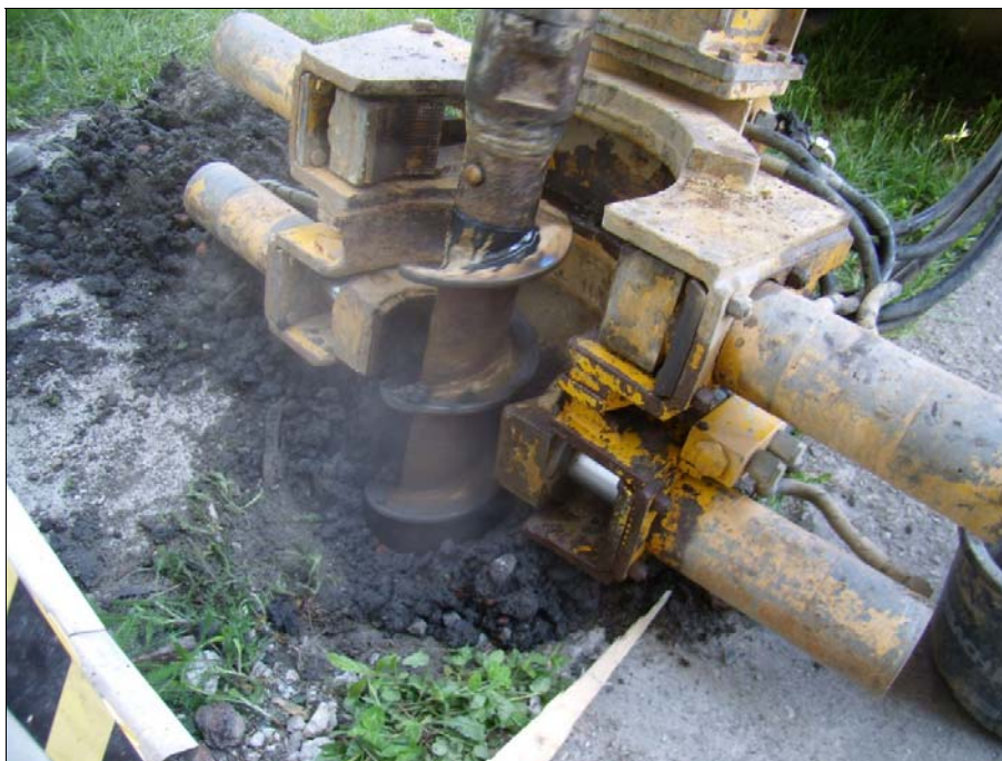
Obrázek 33 Odval Hedvika – realizace vrtů pro termometrické sondy
